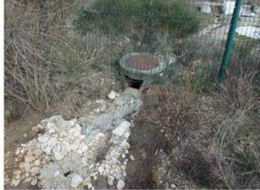
**Illustration 13 : Entonnement béton dégradé en amont de la station de traitement**
