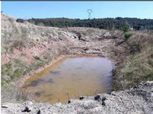
**Illustration 34 : Bassin d'orage partiellement rempli surplombant les bassins de décantation**
