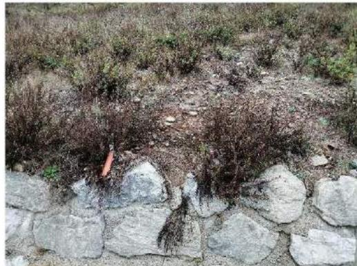
**Illustration 28 : Légère ravine dans le talus supérieur au caniveau bétonné**
